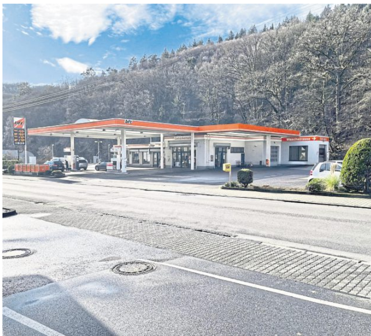
Die Tankstelle in Tiefenstein bleibt nun doch länger geschlossen als geplant. Es gibt Probleme mit der Technik. Gerüchte, sie werde abgerissen, seien aber völlig falsch, beteuern die neuen Betreiber.
